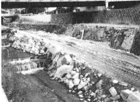
工事中の住吉川
