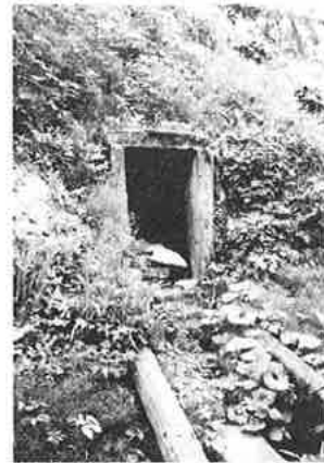
入口をコンクリートブロックで補強した横井戸。
