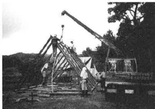
ダイニングテントの骨組み 大幅に強化した耐雪構造
