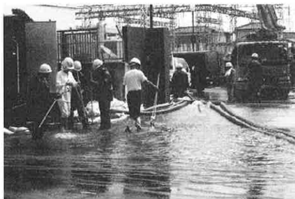
藤見変電所 排水の様子(新潟市藤見町)
