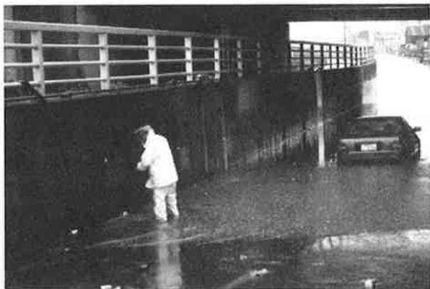
冠水部を通過しようとして浸水した車と排水の様子 (新潟市川岸町)
