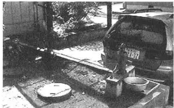
雨水タンク1:手押しポンプの下に2-のタンク
