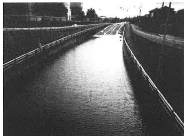
ガード下が冠水(新潟市月見町)
