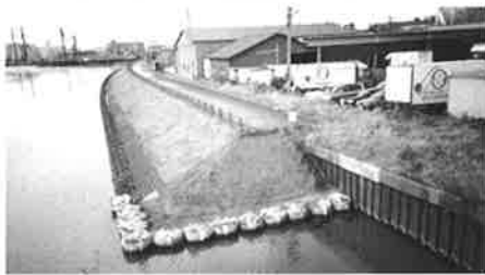
ポンプ場付近右岸
