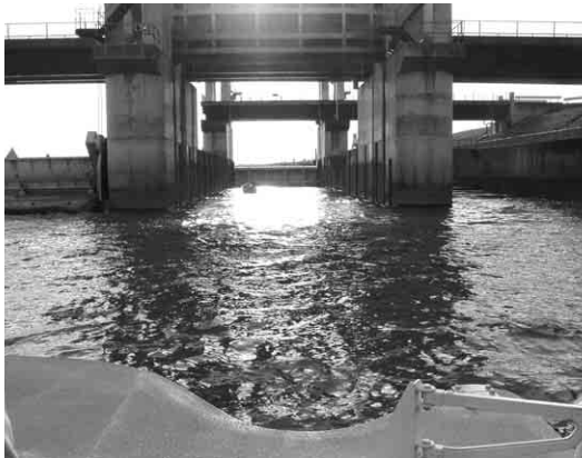
大島頭首工の閘門にて
