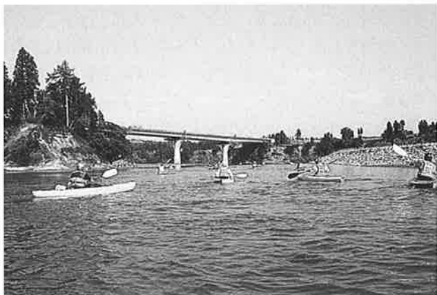
川口橋付近での様子
