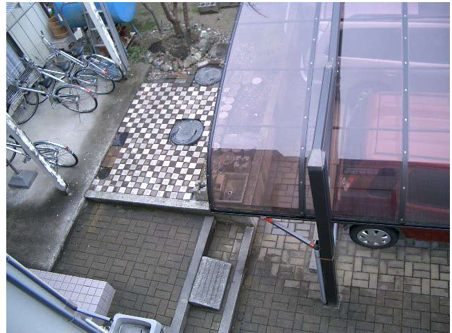
2階から見た、車庫(手前)と雨水タンク (中央、黒い円が点検孔)
