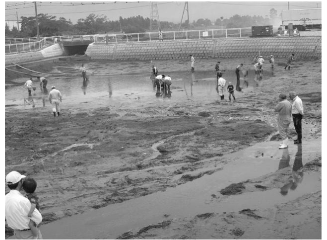
取水口の調査
