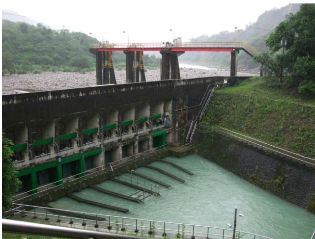
曾文溪から烏山頭ダムへの取水口 (取入れ口が2段になっている)
