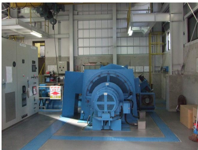
写真1・横軸フランシス型タービン
