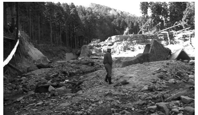
泥流で寸断された途中の道路
