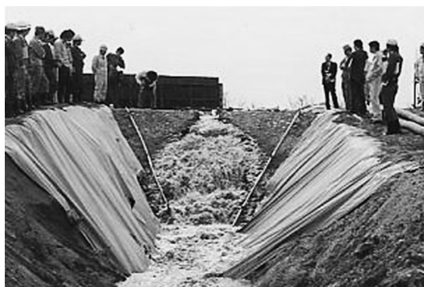
写真6 薬液注入強化堤防・越流開始後1時間経過状況(植木組・福田石材・新潟大学による共同実験、昭和59年4月)
