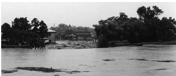
写真4 2004年7月13日刈谷田川・中之島地点での破堤直後の状況（約400年前に立地した寺院が壊滅した。石橋栄治撮影・提供）
