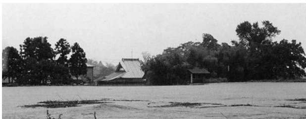
写真3 2004年7月13日刈谷田川・中之島地点での破堤直前の状況（石橋栄治撮影・提供）
