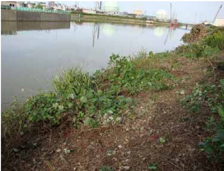
川側、堤防斜面半分ほど伐採。
