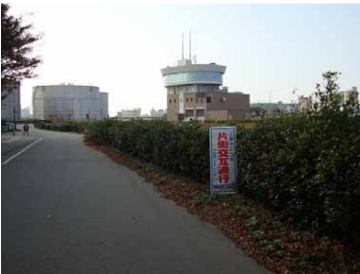
道路側伐採完了。
