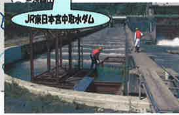
宮中取水ダム魚道に設置の捕獲用トラップ
