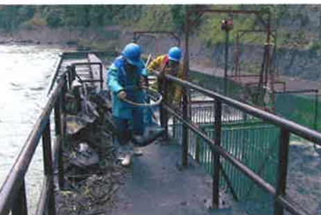
西大滝ダム魚道に設置したトラップに鮭が入ったのを捕ける
