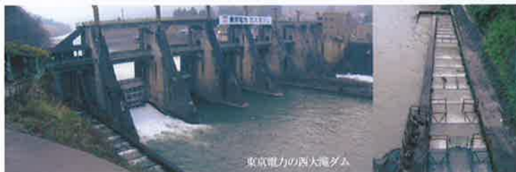
西大滝ダム魚道に設置の3段式のトラップ
