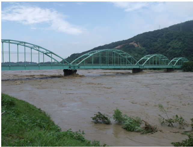
明治以降最大となった阿賀野川洪水（馬下橋地点、2011・7・30、大熊撮影）
