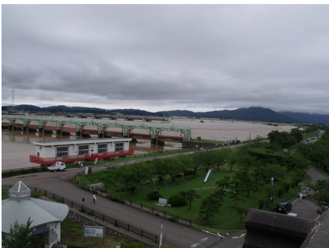
洪水を見事に流下させている大河津分水（2011・7・30、大熊撮影）一手前に見えるのが現可動堰、奥に見えるのが完成間近の新可動堰—
