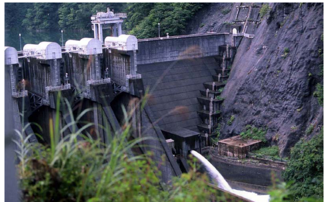
出し平ダムと堆砂放流口
