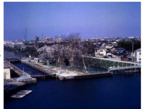
中島閘門（国指定重要文化財）
