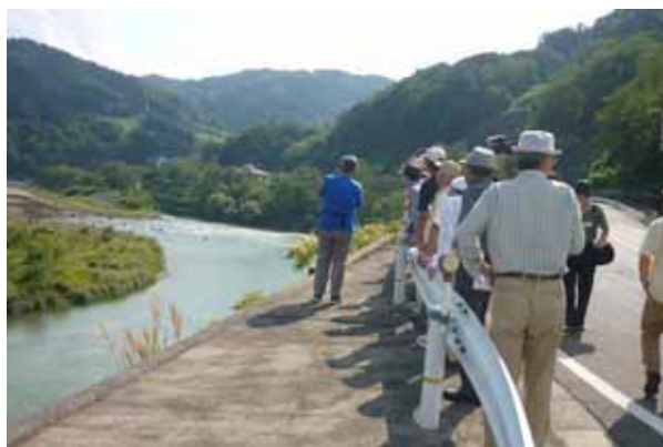
発電用放水口からのみ水は流れる
