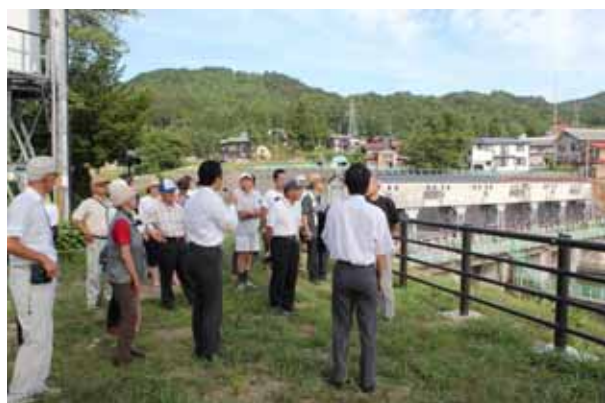
沈砂池を望む
