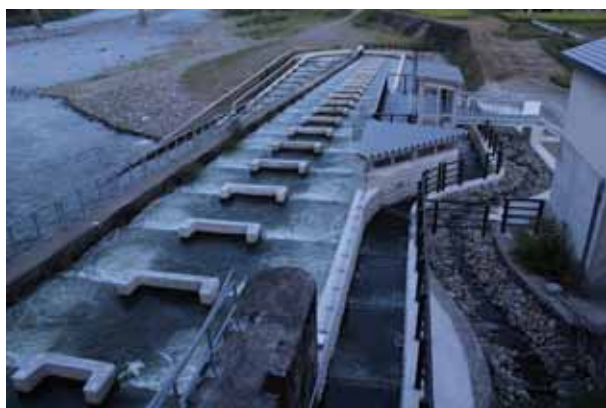
夕暮れの宮中取水ダム魚道を望む
