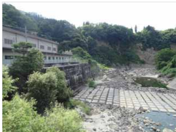
発電所前の川に水はない
