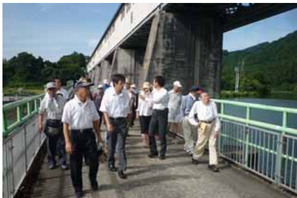
宮中取水ダム堰堤を歩く
