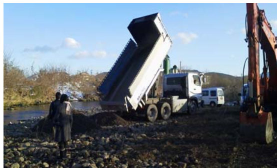
砂利を敷き詰める
