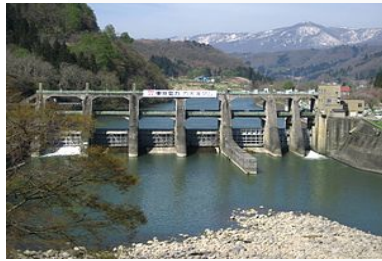
東京電力の西大滝ダム
