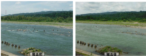
ほくほく線橋梁上流：ブロック撤去前後
