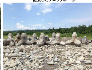
撤去したブロックの一部
