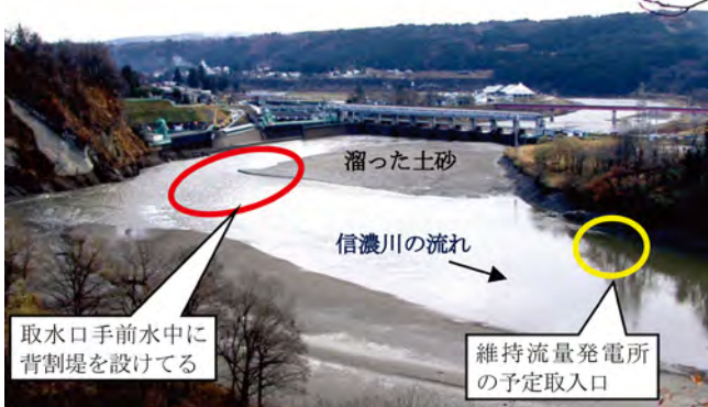
2008.12.5 水を抜き切った宮中取水ダム湖の状況
