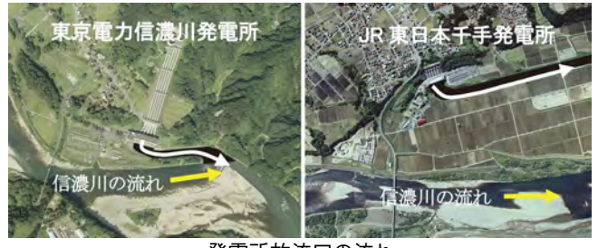
発電所放流口の流れ
