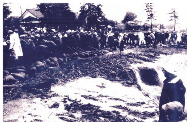
写真：西川堤防切れ補修の土のう積み（撮影者不明）
