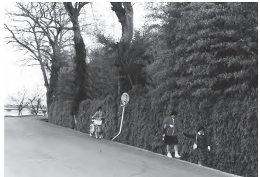
写真2 桂川右岸堤防の笹垣
