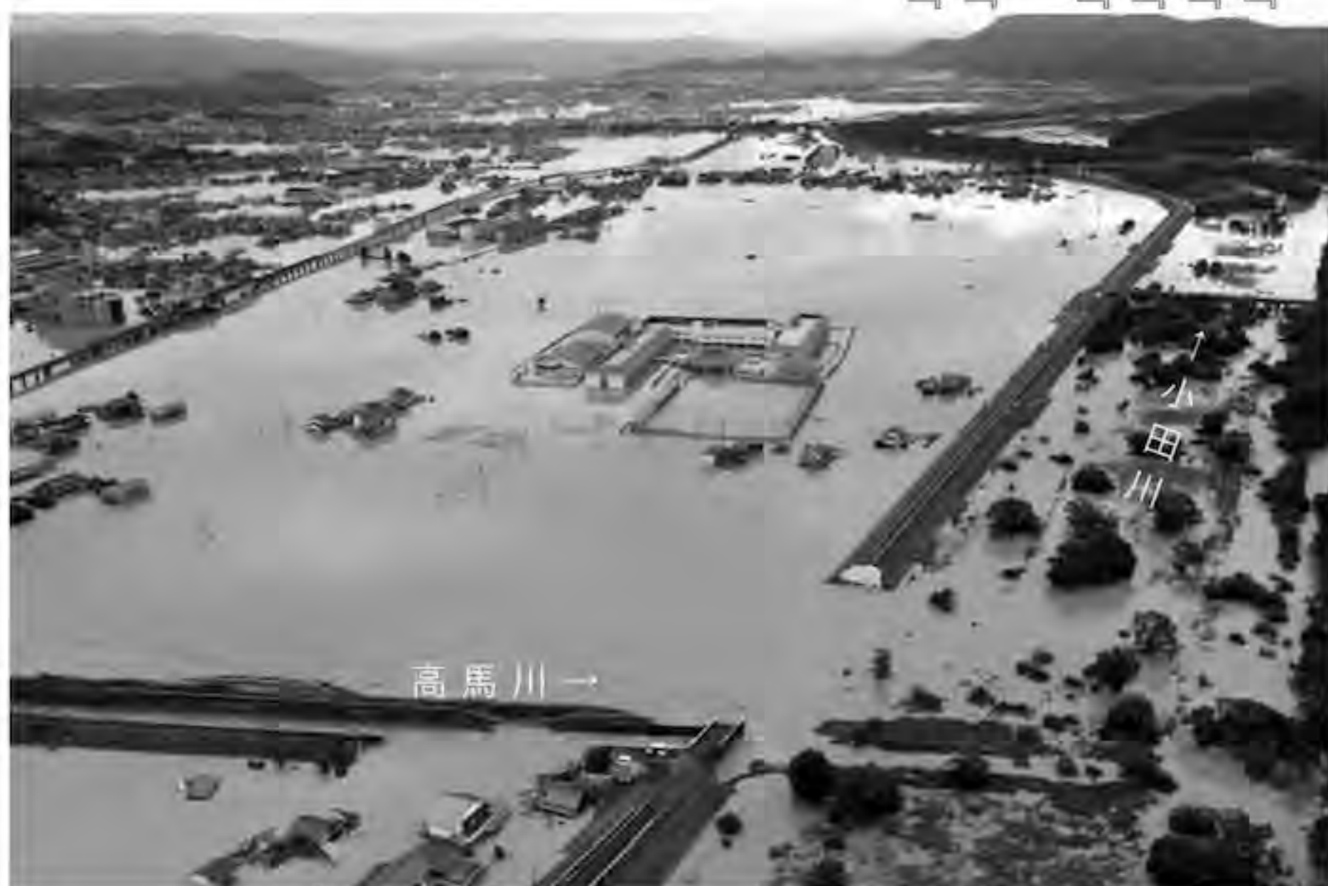
写真1 倉敷市真備町の小田川・高馬川合流点の破堤氾濫
