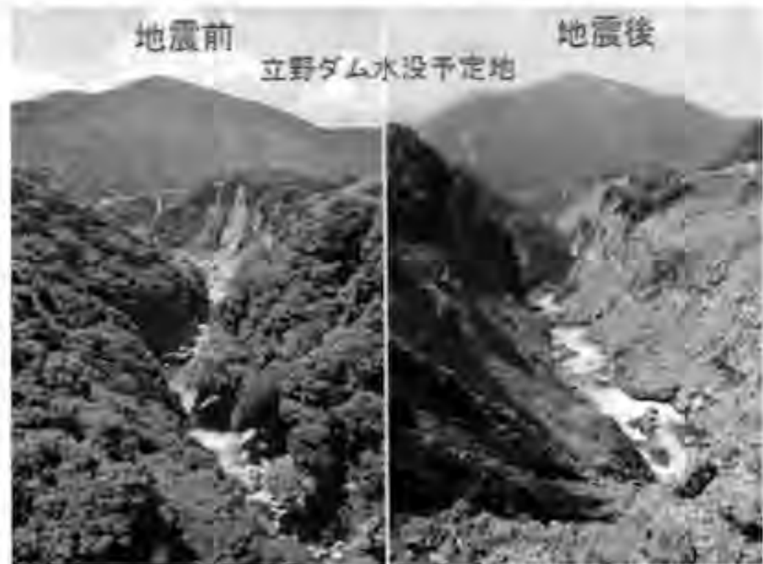
写真4 立野ダムサイトの熊本地震による崩壊状況 (「立野ダムによらない自然と生活を守る会」)
