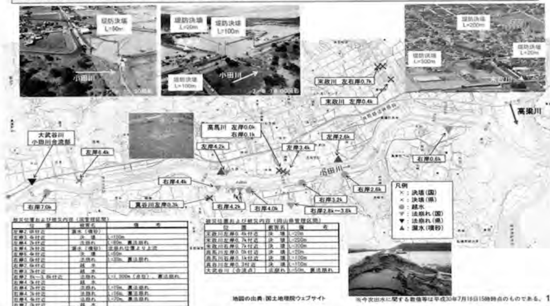
図6 小田川における堤防被害状況（国土交通省岡山河川事務所「高梁川水系小田川堤防調査委員会資料」2018・7・27）
